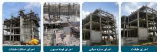
اجرای اسکلت طبقات
